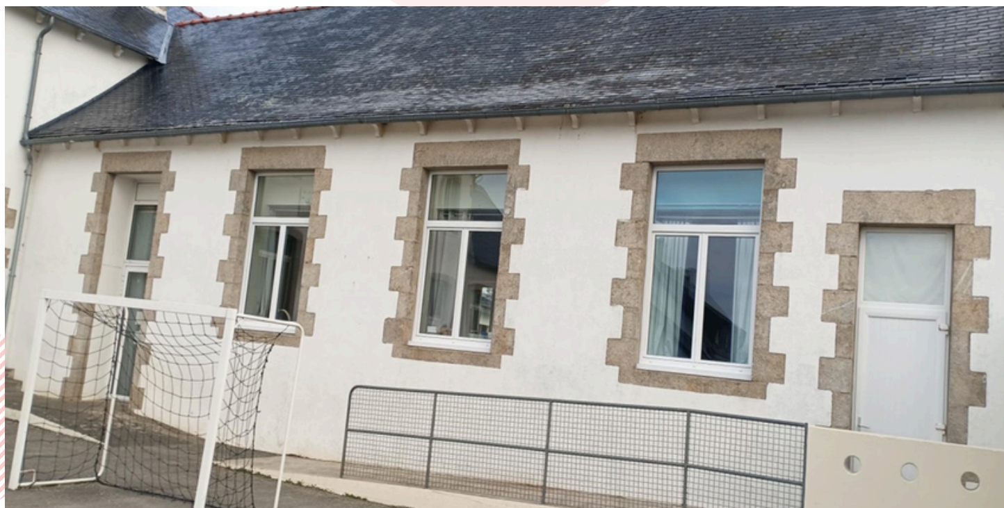
Remplacement de 3 fenêtres à l'école.
